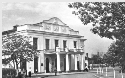
Будівля українського музикально - драматичного театру ім. М. Кропивницького по вул. Театральній, 4 (1954 р. арх. Л. Дворець)
