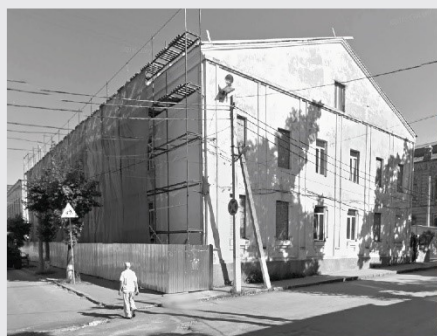
Стан до реконструкції
