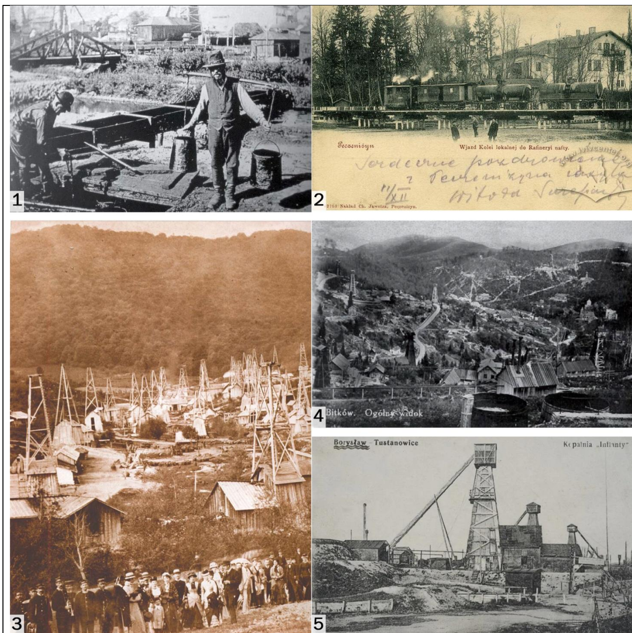
Рис. 1.7. 1. Ручне збирання нафти. 2. Локальна залізниця на нафтоперегінному заводі в с-щі Печеніжин, поштівка 1904 р. 3. Нафтовий промисел у с. Слобода-Рунгурська (тепер с. Слобода Коломийського району), 1881 р. 4. Загальний вигляд Битківського нафтопромислу. 5. Нафтові вишки в Бориславі, поштівка 1917 р.
