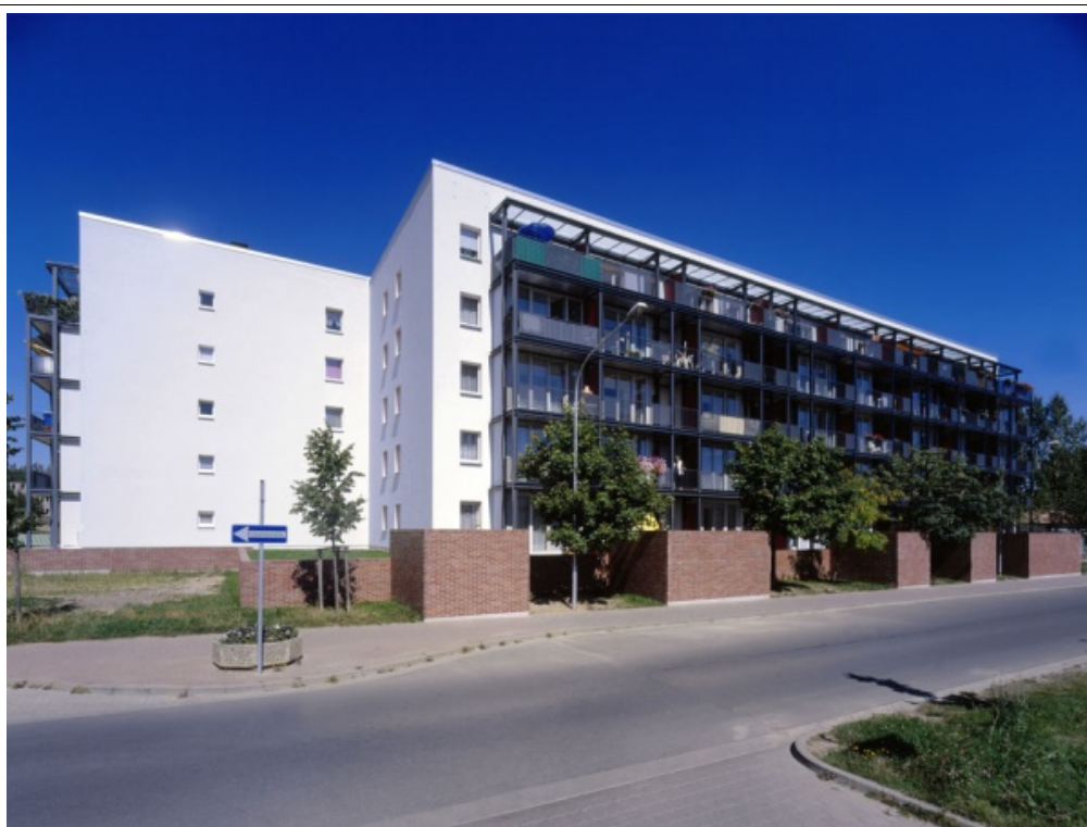
Рис. 1.3.25а. Житловий будинок після реконструкції в Лайнефельді.
