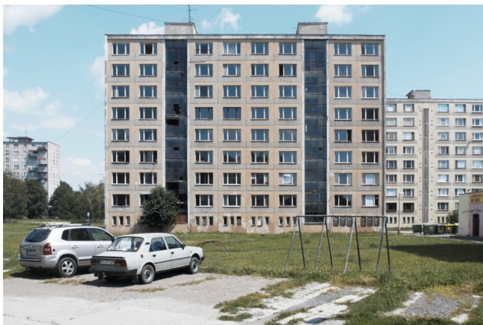
Рис. 1.3.21. Фото до реконструкції житлового будинку Реновація житлового будинку в Рімавська-Собота в Братиславi. Словаччина
